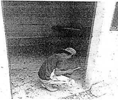
Foto1: Sustitución de piso
