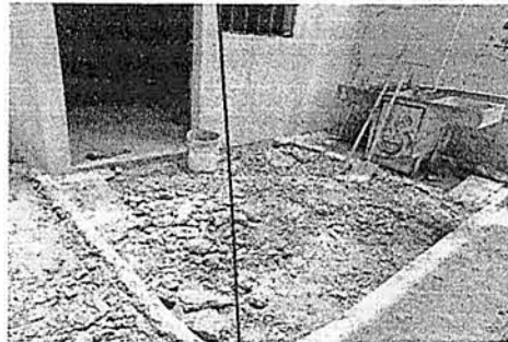
Foto 4: Sustitucion de torta de concreto
